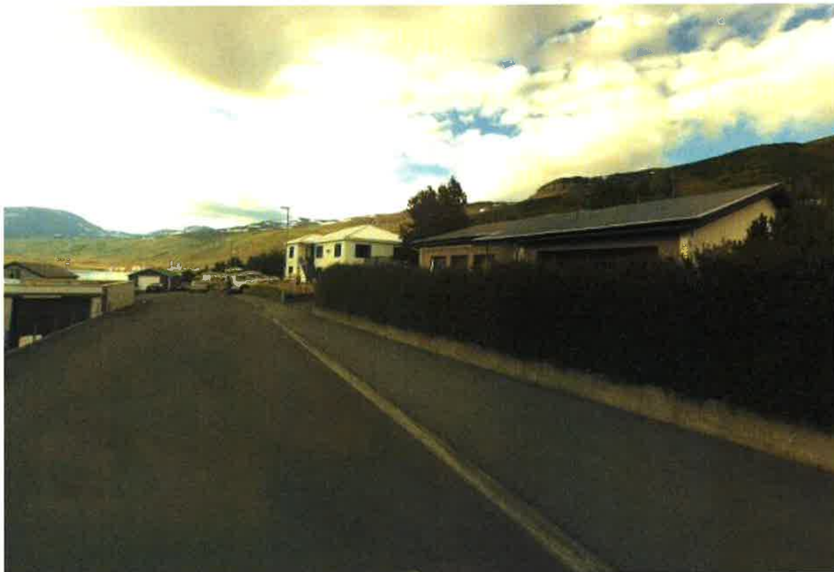
Mynd 2-3. Við Hlíðarendaveg. Hér er komin gangstétt 1,5 metra breið.
