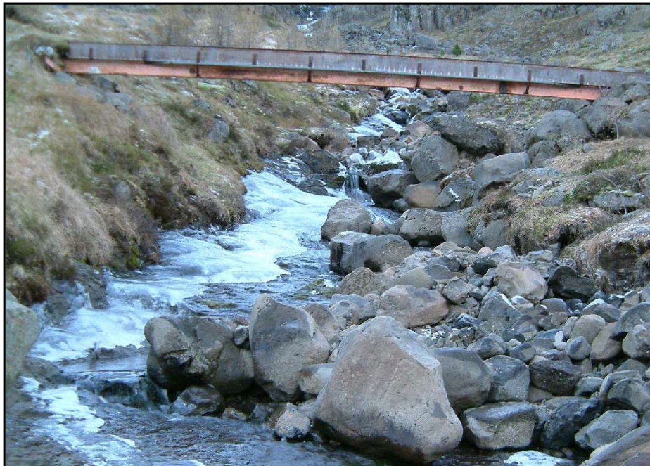
Mynd 11 Rétt ofan við byggðina liggur víða mikið af grjóti í farvegi árinna sem bíður þess að skolast lengra niður farveginn. Áin rennur á klöpp.
