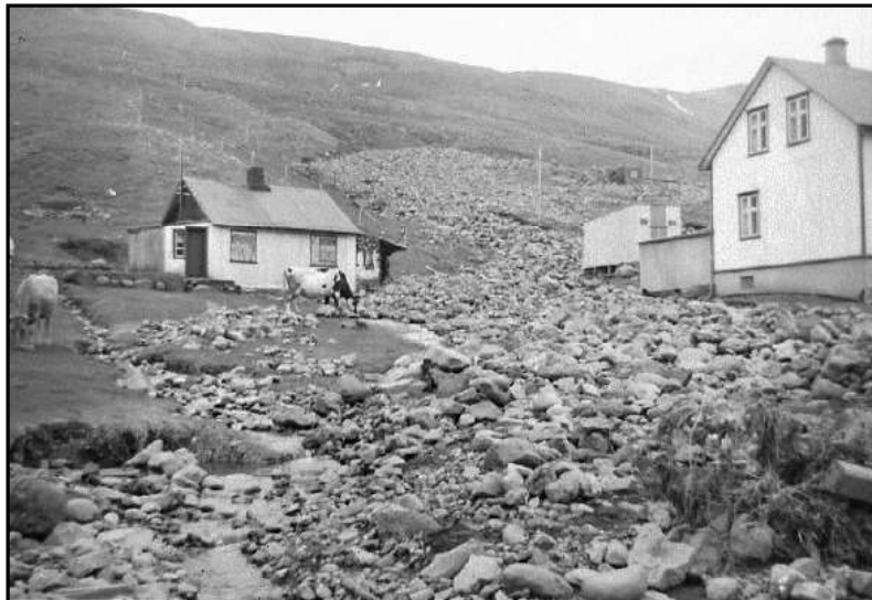
Grjótá. Til hægri er Bleiksárhlíð 67, 1940.
