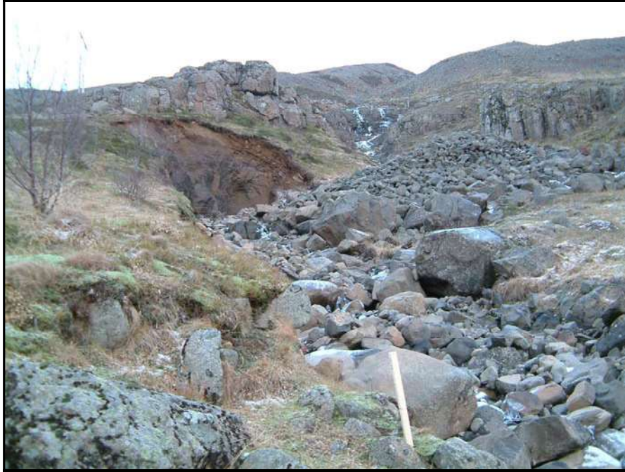
Mynd 10 Mikill grjótframburður sem stöðvast hefur í farvegi árinna rétt ofan við byggðina beinir nú rennsli að vinstri bakka árinna (horft upp ána) og veldur talsverðu rofi úr bakkanum.
