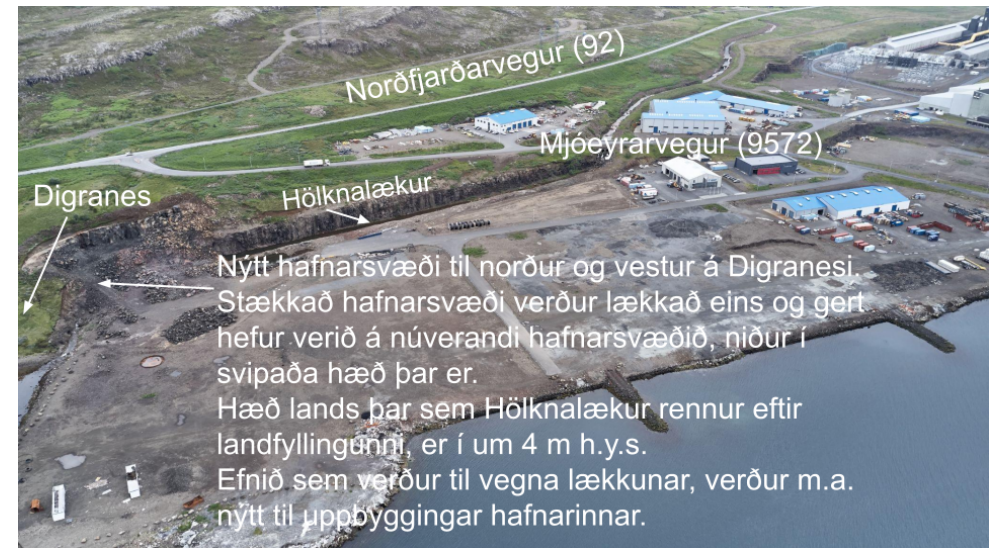
Mynd 3.2: Myndin er tekin til norðausturs yfir 2. áfanga stækkunar hafnarbakka Mjóeyrarhafnar sumarið 2019. Þarna sést hvernig hafnarsvæðið er mótað inn í berggrunninn. Með þessu fæst tvennur ávinningur. Hafnarsvæðið verður samfellt með litlum halla og því aðgengilegt til athafna, en samhliða fæst gott efni úr berggrunninum sem nýtilegt er til framkvæmda við þróun og stækkun hafnarinnar m.a. landfyllinga. Með þessu deiliskipulagi er hafnarsvæðið stækkað áfram til norður og vesturs yfir á Digranes.
