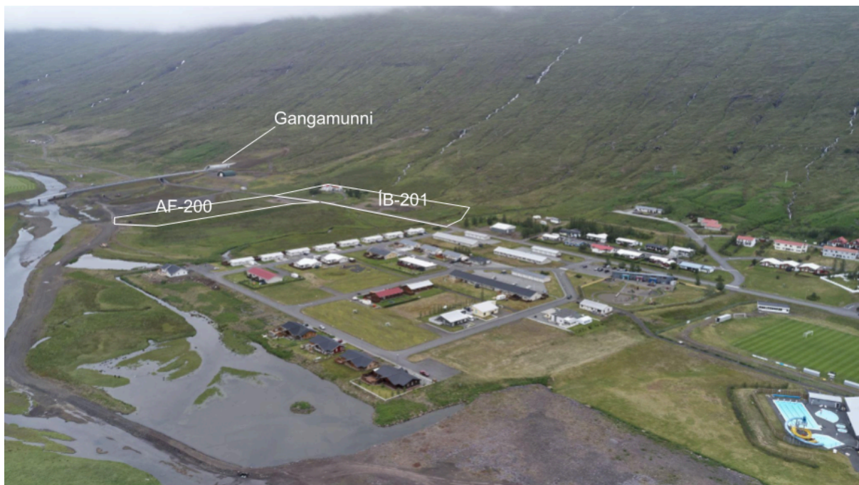
Mynd 1: Myndin sýnir aðalskipulagsreiti AF-200 og ÍB-201 ásamt gangamunna Norðfjarðarganga og aðlægrri byggð. Myndin er tekin 2019 en íbúðarbyggðin í forgrunni á myndinni er nú næstum fullbyggð og þörf fyrir fleiri íbúðarhús.
