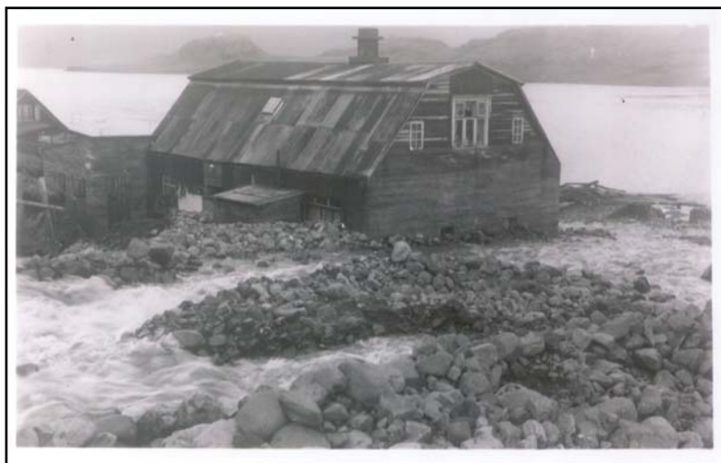
Ljósá. Hús við ána skemmdist talsvert, 1946.
