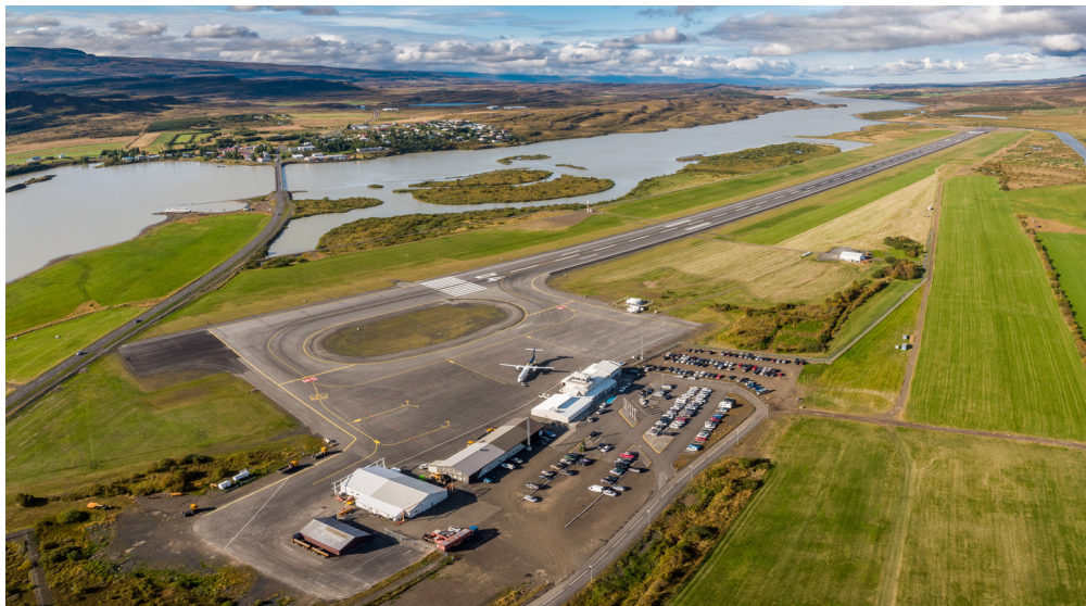
Á Egilsstöðum, sem er í 30 mínútna akstursfjarlægð frá Reyðarfirði, er innanlands- og millilandaflugvöllur. Mynd: Ragnar Th. Sigurðsson
